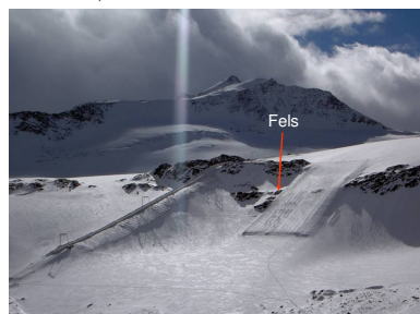
Abb. 3: Technische Maßnahmen auf der Piste im Bereich einer Felsinsel
